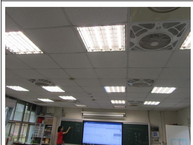
全面更換省電 LED-班級教室
