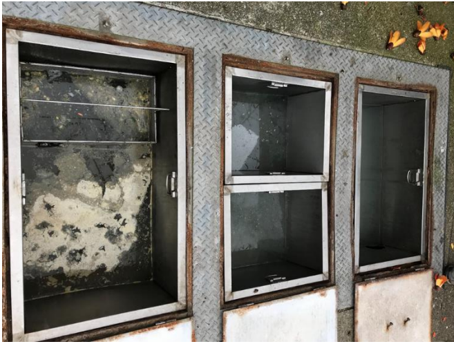
設置截油槽處理廚房污水
