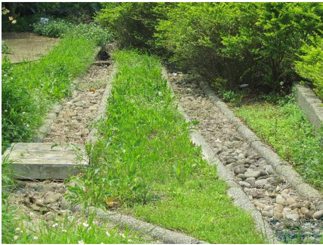
校區水溝運用礫石鋪面透水性更高
