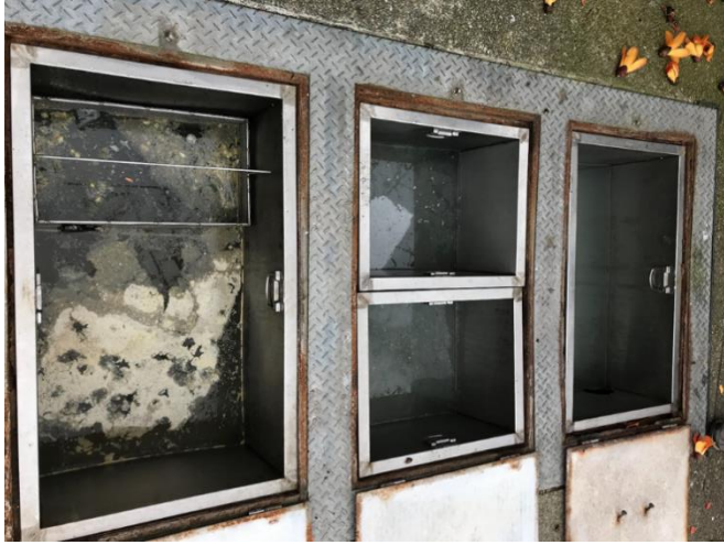
設置截油槽處理廚房污水
