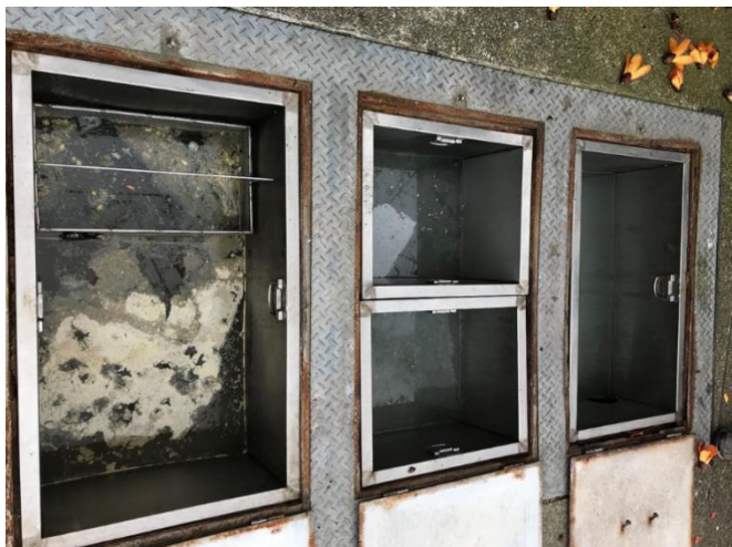
設置截油槽處理廚房污水
