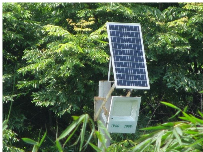
設置太陽光電照明設備系統
