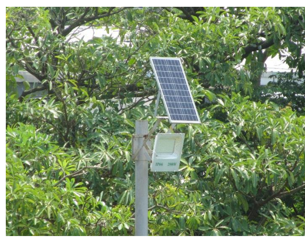
設置太陽光電照明設備系統
